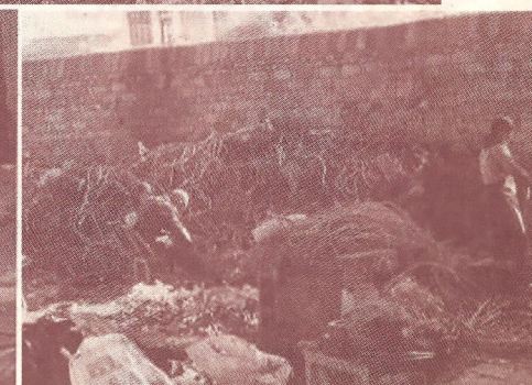
手作業でビニールと銅を分けている
