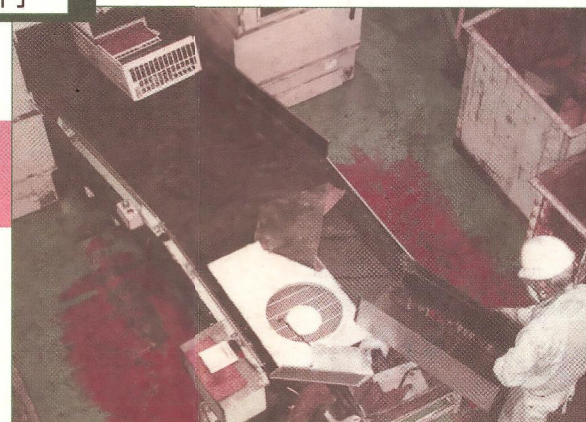
解体が終了したエアコン室外機は、みごとにバラバラ状態。ここで、素材別にコンテナに投げ込まれる。
