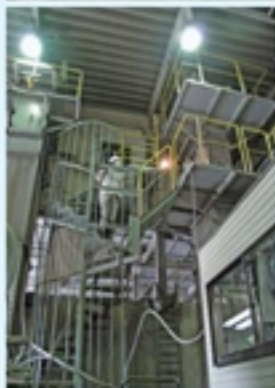
バケットエレベーターの修理
