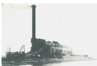
1931年(昭和6年)に完成した滝頭じんかい処理所。
