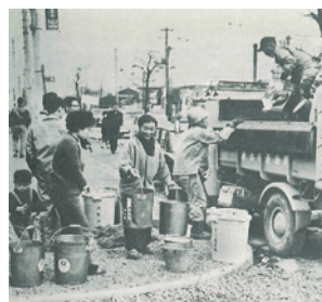
1964年（昭和39年）。東京オリンピック開催に備えて、定時制収集を実施する地域が拡大。機械式収集車も導入された。
