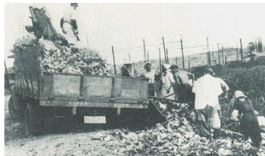
1958年（昭和33年）。鶴見区矢向処理場に大型車からゴミを搬入。このあと、石炭ガラによる覆土作業を行う。
