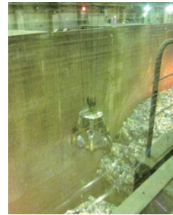
写真3：ごみピットから操作室までの高さは約30mもある。
