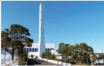
写真1：金沢工場の全景。煙突は130mの高さがある。
