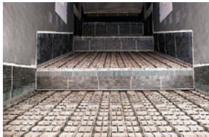
写真4：焼却炉の内部は階段状になっていて、ごみは燃えながら移動していく。
