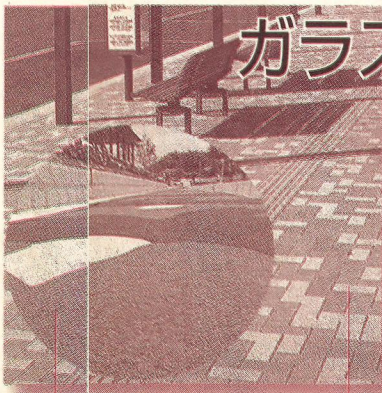
ブロック舗装への利用 ▲公園のカラー舗装への利用
